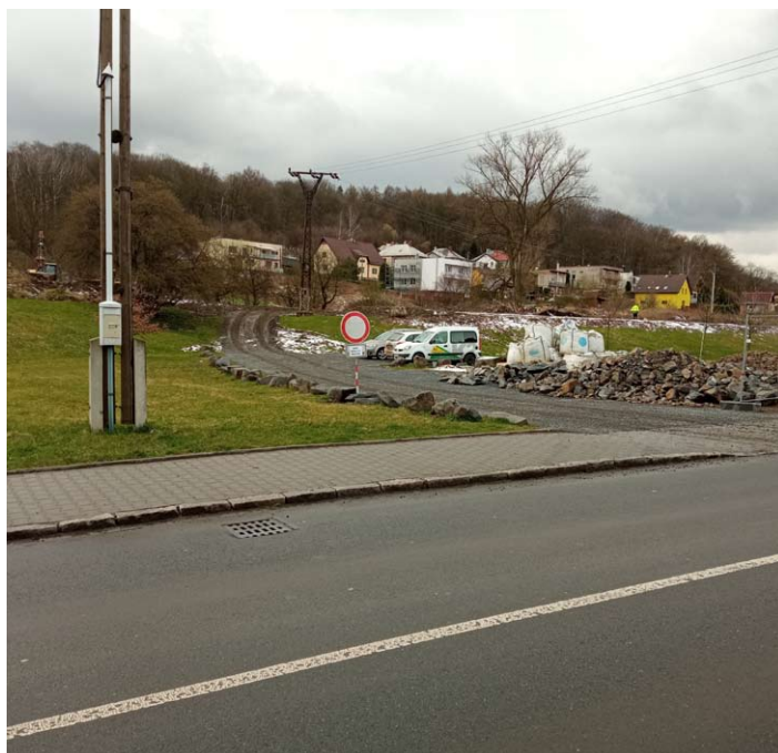
■ Příjezd na připravovanou plochu z ul. Hlučínské
