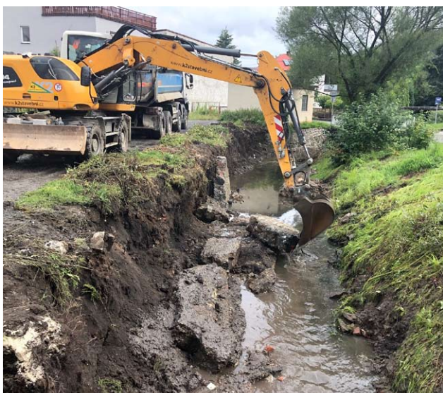
■ Ludgeřovický potok před a po opravě opěrných zdí
