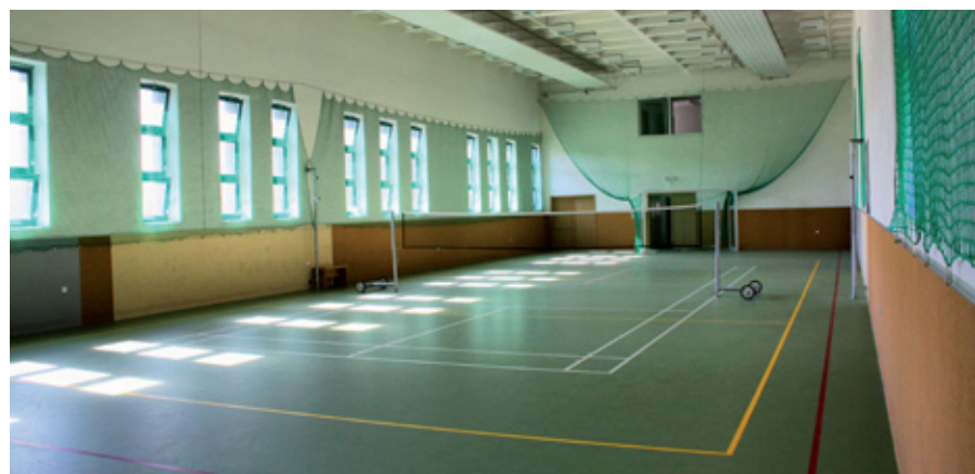
Pohled na nově upravenou víceúčelovou halu
