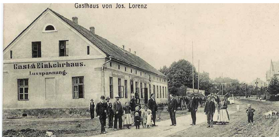
■ Zatrubnění Petřkovického potoka v roce 1911 vytvořilo prostor pro další rozvoj obce.
